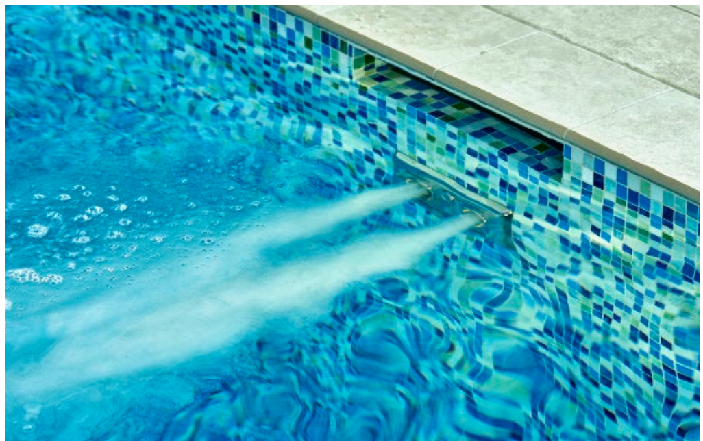
Bild oben rechts: Hier zeigt sich die saubere Verarbeitung der Beckenauskleidung inklusive der Verbindung zur Beckenumrandung aus Naturstein von Meyer Bauabdichtung.
